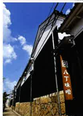
『カクキュー』は、1645（正保2）年創業以来、味噌造り一筋。大豆と塩のみを原料にした八丁味噌で商う。本社事務所（上）や蔵（下）は、平成8年、最初の登録文化財となった。資料館も併設され、事前予約があれば蔵見学も可能だ。
